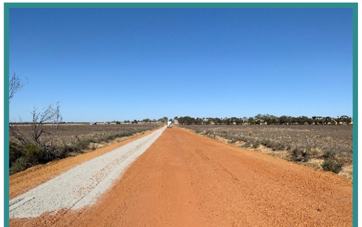
Kondut West Road
